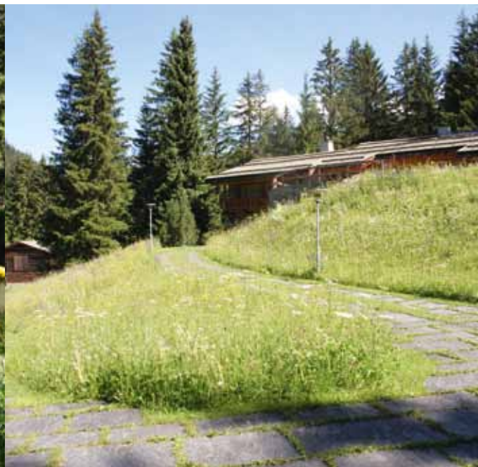
Die Auffahrt zum Haus besteht aus Granitplatten und fügt sich harmonisch in die Landschaft ein.
